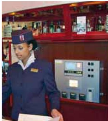
**Eines der Schweizer Referenzobjekte von APS ist das Airport Hotel in Basel. Hier das Anzeige- und Bedienmodul des Gebäudetechnik-Störmeldesystems TS 400.**
